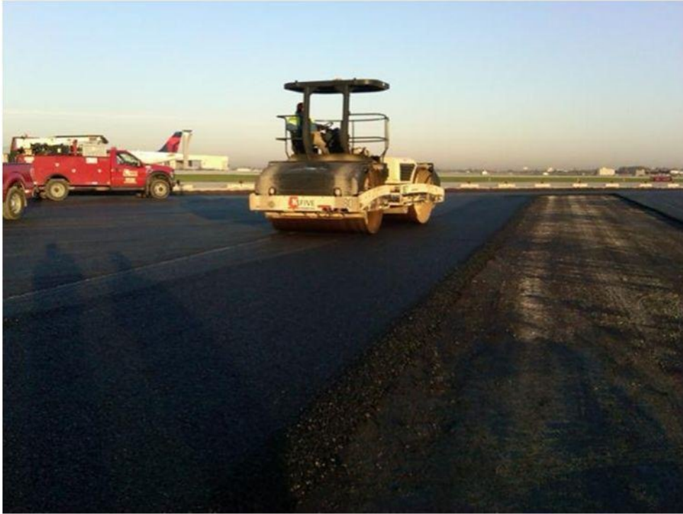
Figura 2: Compactación de capa ligante (2011). Colocación fue a 20-30°C abajo de las temperaturas normales de mezcla caliente
