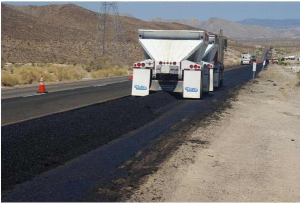
Figura 4: Mezcla Tibia con Asfalto Modificado con Caucho Molido en El Centro, CA. No hay humos visibles en contraste con mezclas regulares modificadas con caucho molido
