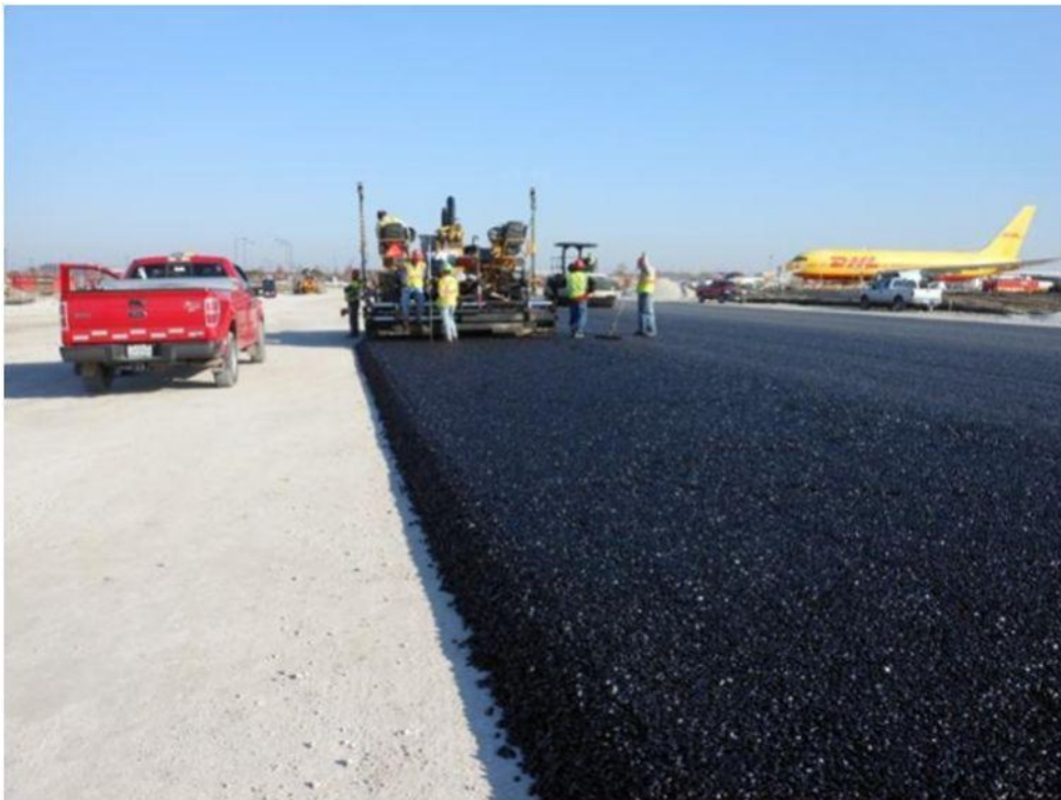
Figura 3. Mezcla ATPB siendo pavimentada. Debido a la menor temperatura de colocación la compactación puede ser iniciada más pronto
